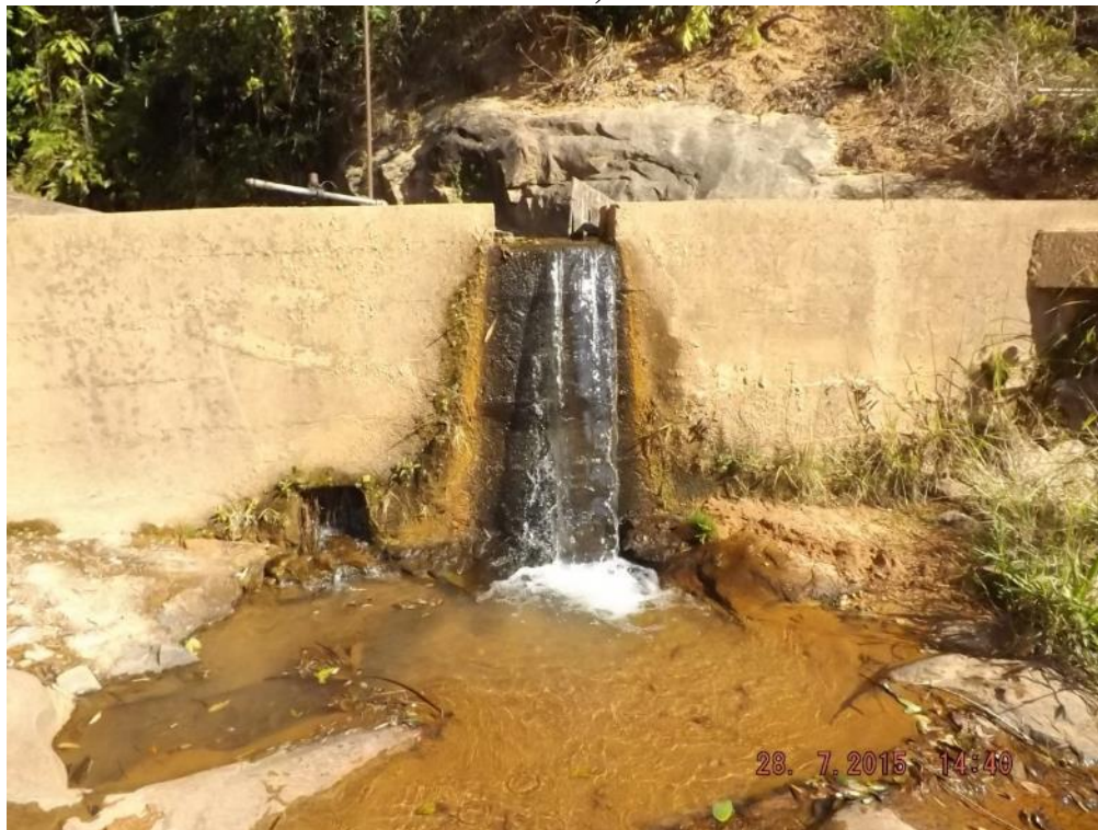
Figura 57: Barragem de Captação (Local: S 19° 13'25.92" W 42° 52'37,92"/Altitude: 441m)
