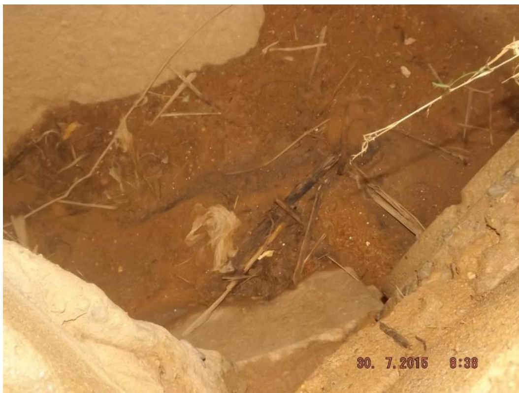
Figura 114- Resultado do carreamento de sedimentos/resíduos para a rede drenagem
