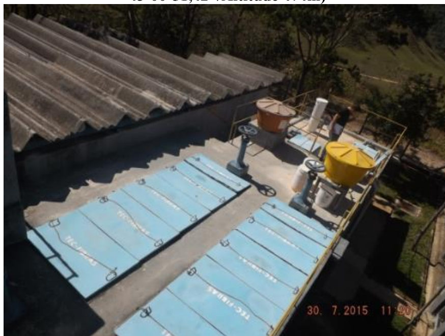
Figura 35: Vista Geral do processo de Tratamento. Local: (S 19°15'0,42" W 43°00'51,42"/Altitude 474m)
