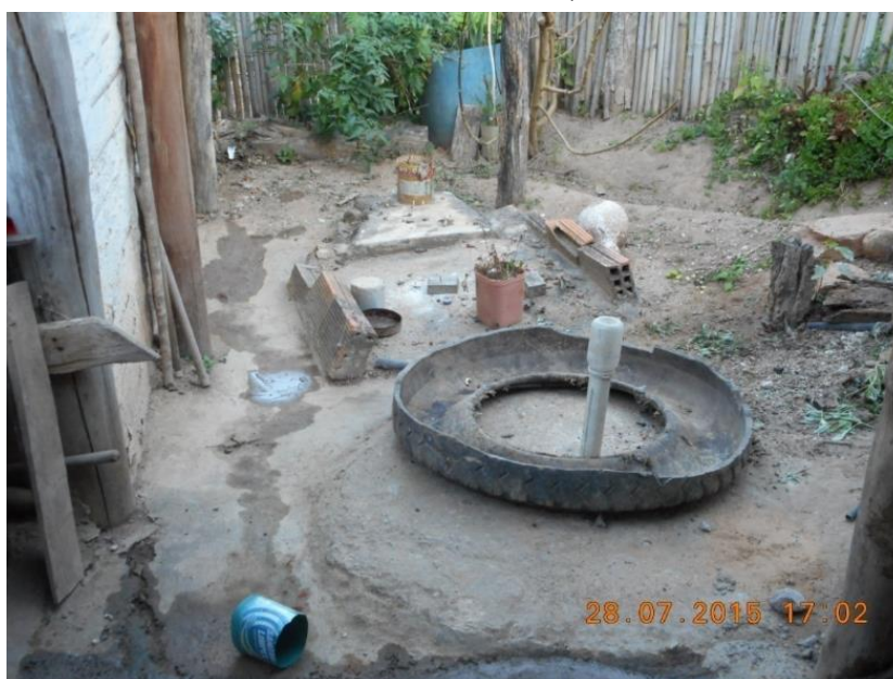
Figura 63: Fossa negra localizada na sede do município de Ferros (Local: S 19°11'42,72" W 42°56'13,38" )
