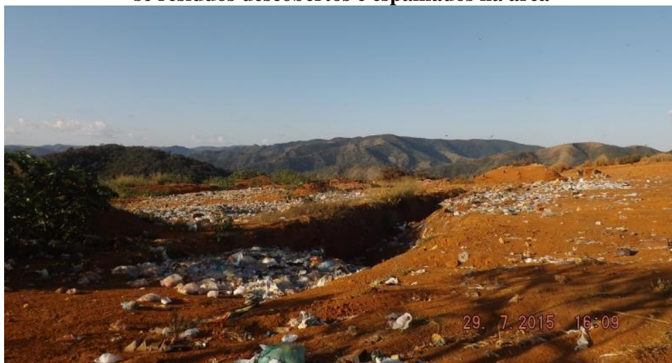
Figura 103 – Aspecto geral da área onde é feito o descarte dos rejeitos na UTC, percebe-se resíduos descobertos e espalhados na área
