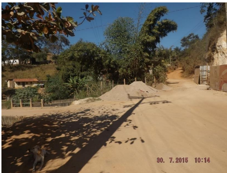
Figura 113–Área contribuindo com carga de sedimentos obstruindo a pouca drenagem existente (ineficiente) na cidade
