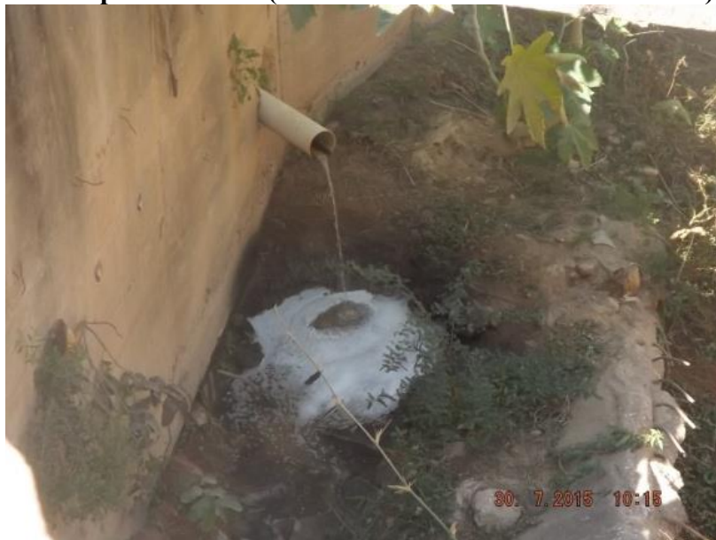
Figura 59: Ponto de lançamento de esgoto doméstico in natura localizado na sede do município de Ferros (Local: S 19°15'3.12" W 43°0'46.74")
