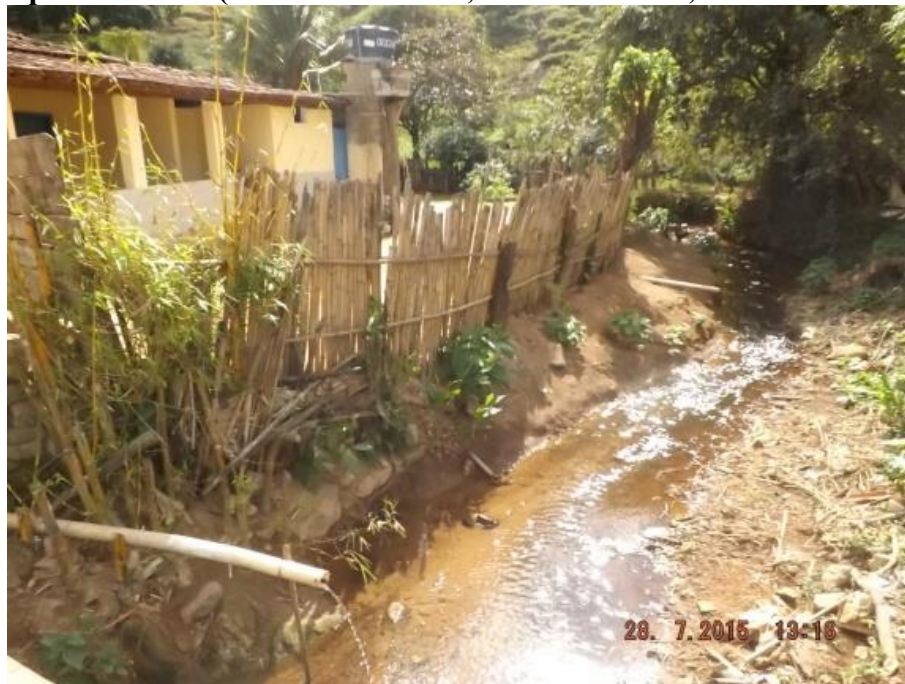
Figura 75: Lançamento de esgoto doméstico in natura em Cubas, Zona Rural do município de Ferros (Local: S 19°17'17,04" W 42°47'29,76" / Altitude: 897m).
