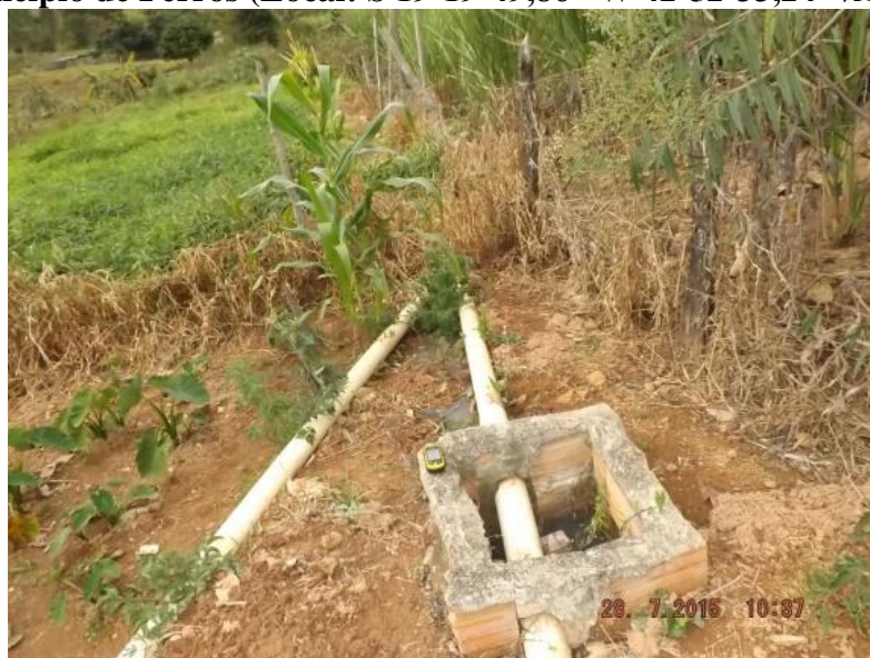
Figura 69: Lançamento de esgoto doméstico in natura em Esmeraldas de Ferros, Zona Rural do município de Ferros (Local: S 19°19'49,86" W 42°52'33,24" /Altitude: 315 m)
