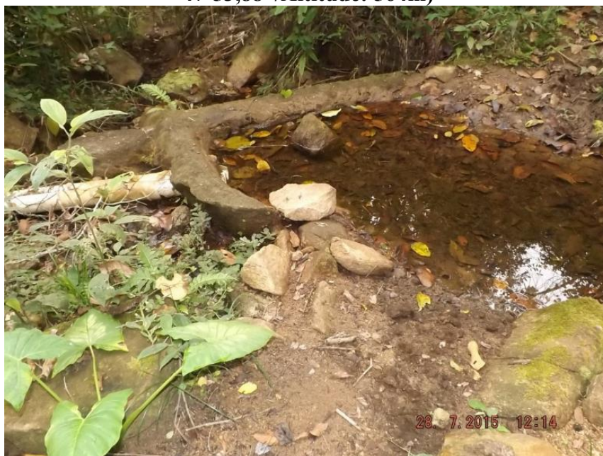
Figura 52: Barragem de Captação no distrito de Cubas (Local: S 19° 17'16,68" W 42° 47'53,88"/Altitude: 564m)
