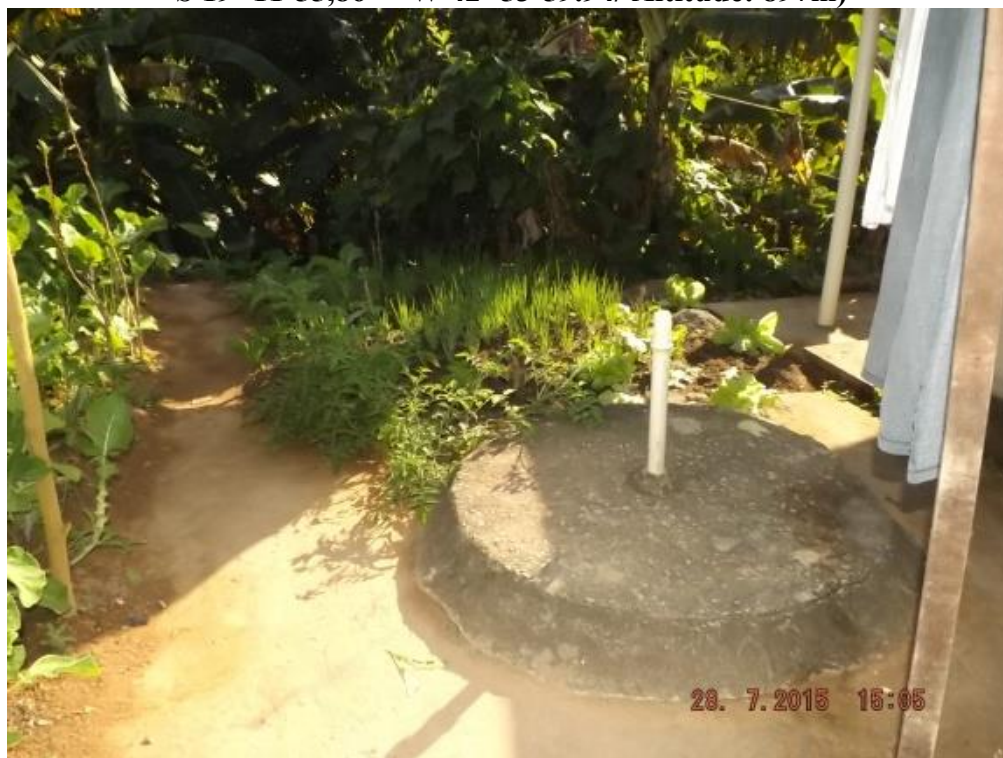
Figura 88: Fossa negra em Sete Cachoeiras, Zona Rural no município de Ferros (Local: S 19° 11'55,86" - W 42° 53'59.94/ Altitude: 897m)
