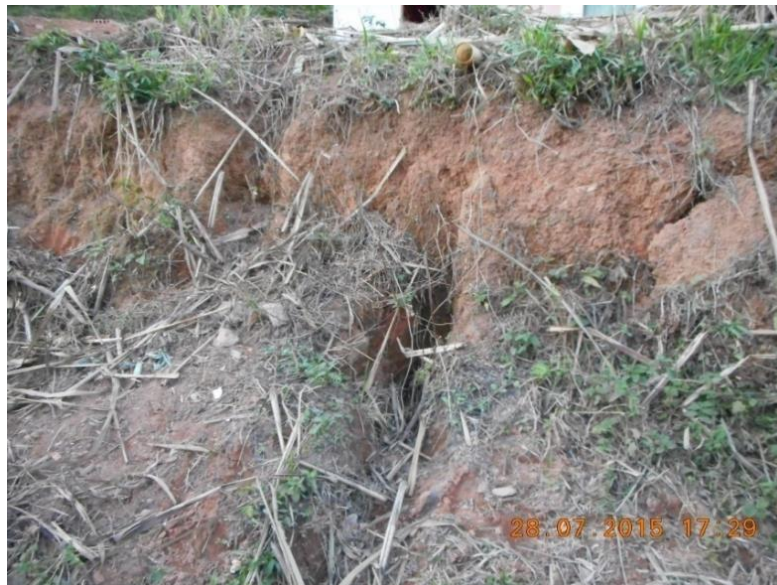
Figura 62: Ponto de lançamento de esgoto doméstico in natura , localizado na sede do município de Ferros
