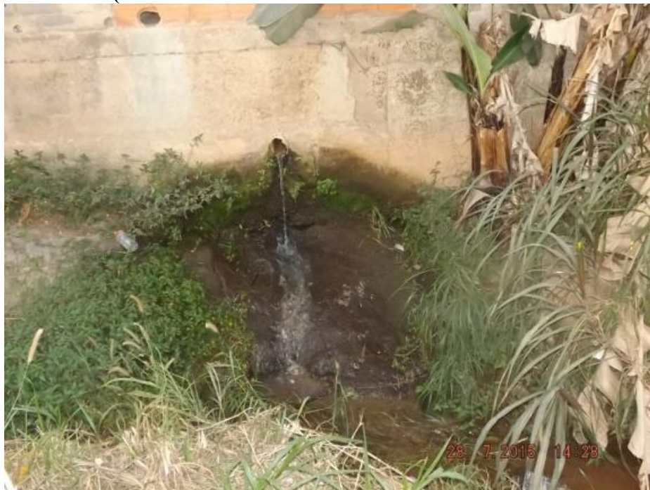
Figura 86: Lançamento de esgoto doméstico in natura localizado na zona urbana de Sete Cachoeiras (Local: S 19° 13'19.26" W 42° 52'39.06" / Altitude: 897m)
