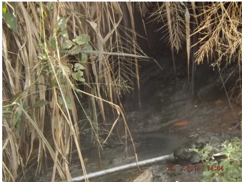
Figura 79: Lançamento de esgoto doméstico in natura em Borba Gato, Zona Rural do município de Ferros (Local: S 19°7'42,12" W 43°0'3,30" / Altitude: 897m)
