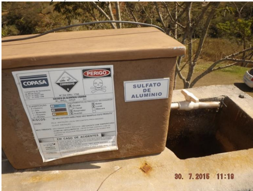
Figura 36: Floculação, Local: (S 19°15'0,42" W 43°00'51,42"/Altitude 474m)
