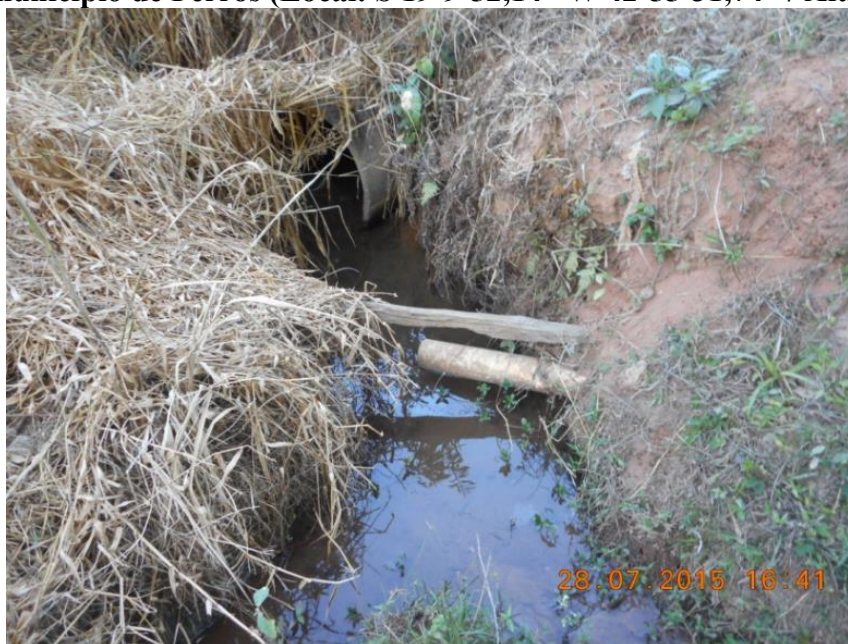
Figura 73: Lançamento de esgoto doméstico in natura no distrito de Santo Antônio da Fortaleza, município de Ferros (Local: S 19°9'52,14" W 42°55'31,74" / Altitude: 897m).
