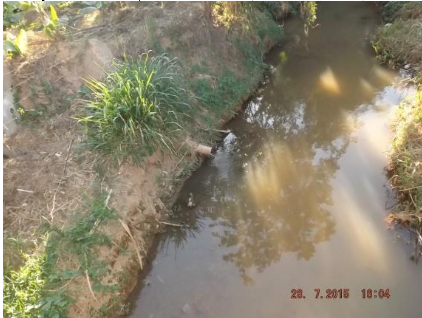
Figura 72: Lançamento de esgoto doméstico in natura no distrito de Santo Antônio da Fortaleza, município de Ferros (Local: S 19°9'53,64" W 42°53'38,04" / Altitude: 897m)
