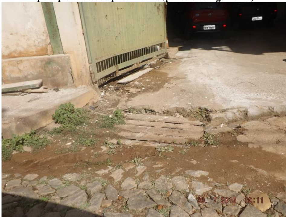
Figura 112–Área na cidade de Ferros com drenagem (ineficiente) pluvial onde água precipitada escoava pela mesma (ponto de alagamento)
